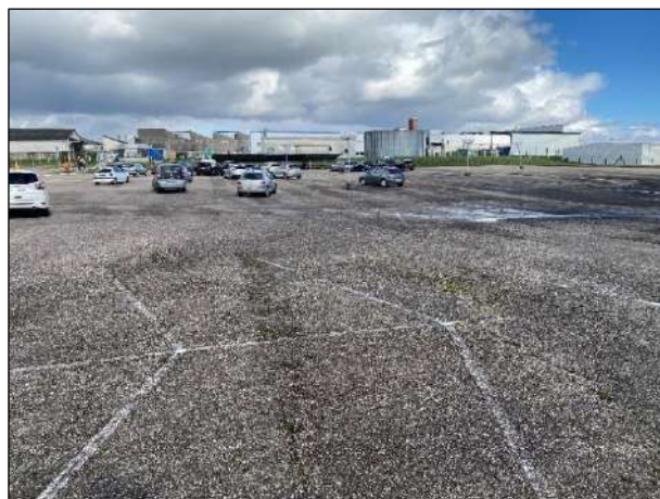
Photographie 10 : Vue du parking à l'est du site vers le nord-est
