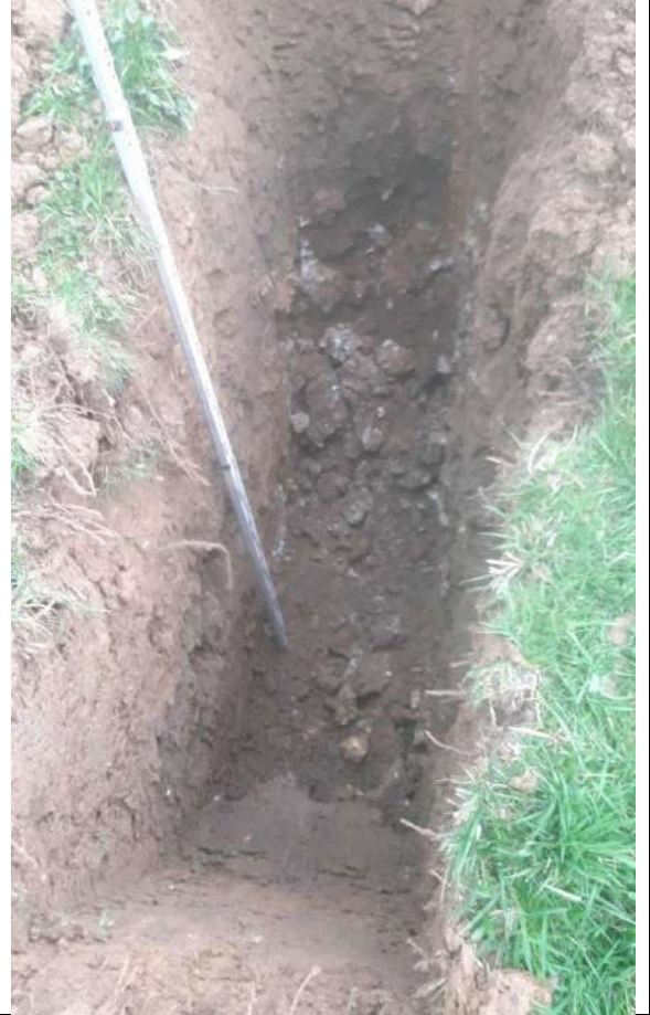
Fond de fouille
