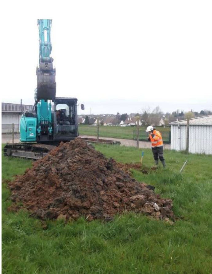
Localisation de la fouille
