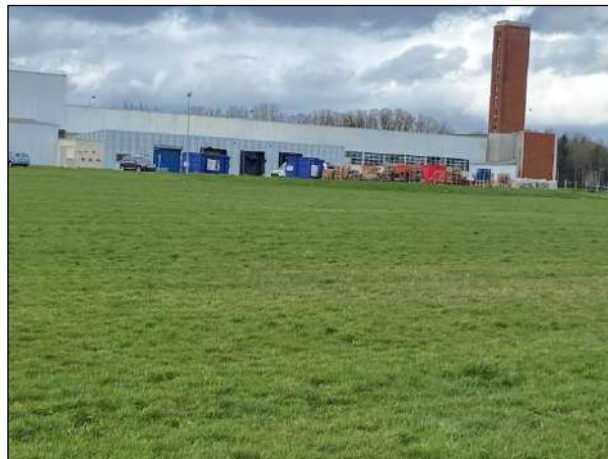
Photographie 8 : Vue des locaux d'Ocytrans depuis l'angle du bâtiment bleu
