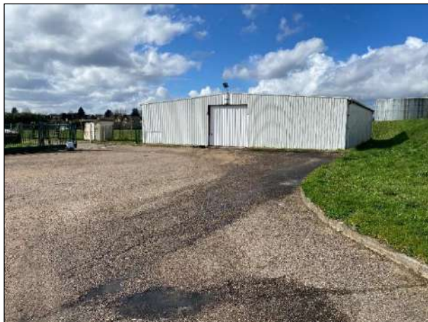
Photographie 7 : Vue du bâtiment blanc
