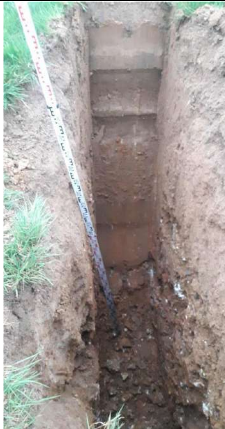
Fond de fouille
